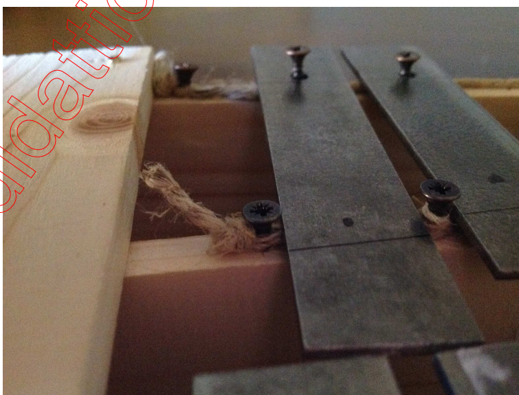
Particolare della sistemazione della corda: lo spago fa un giro intorno alle viti che sono ai lati delle barre.
